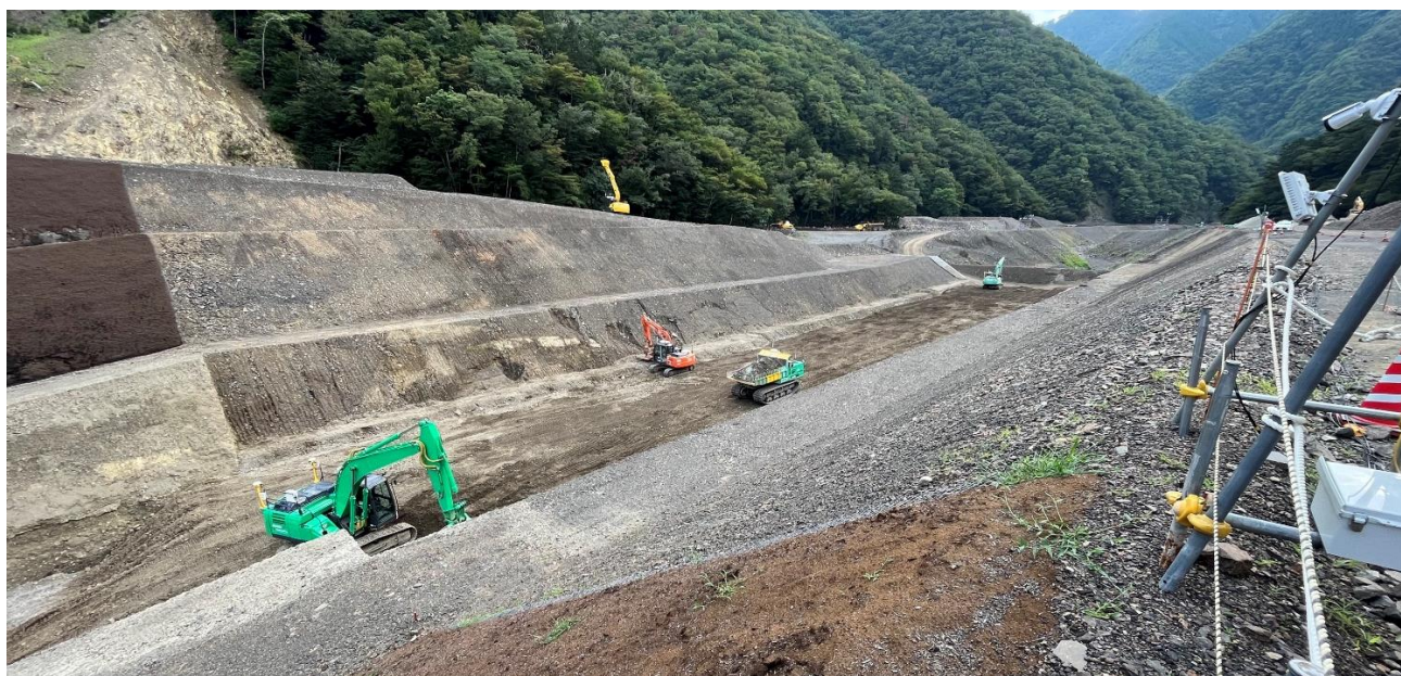
奈良県五條市大塔町赤谷地区上流溪流保全工他工事現場内での検証の様子
