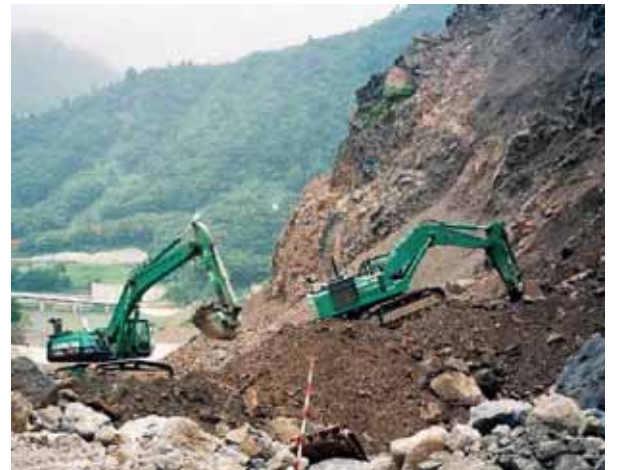
崩壊が続く中で山腹に登坂路設置中の無人機械
