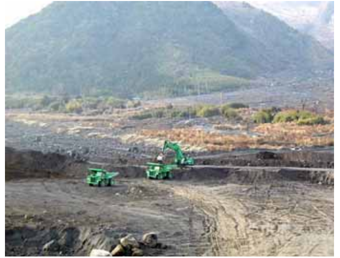
砂防ダム堆砂敷を無人機械で掘削・運搬 地区外へ搬出
