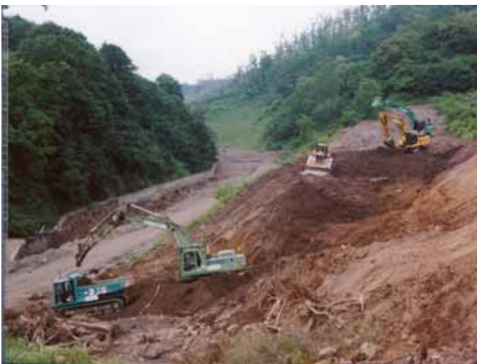
火山灰等が降雨による土石流被害防止の為、仮設沈砂池施工中の無人機械
